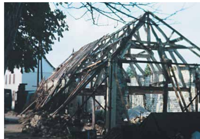
Etat de l'ancienne écurie du XVIIIe siècle avant et après restauration par l'École du Métier:
