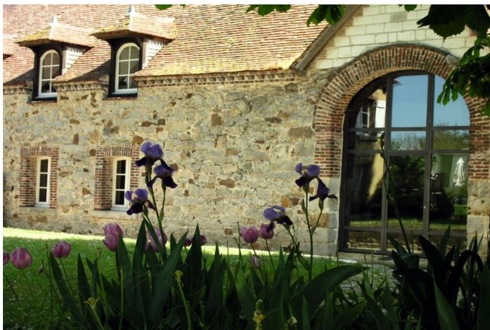
Façade de la grande salle d'exposition, domaine du Tournefou (Aube). Photo Philippe Brame
